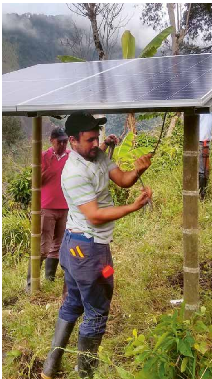
Atelier de planification et d'installation de panneaux solaires et mise en place d'une pompe à eau pour une pisciculture. Projet Semillas de Agua à Cajamarca, Tolima, Colombie.
